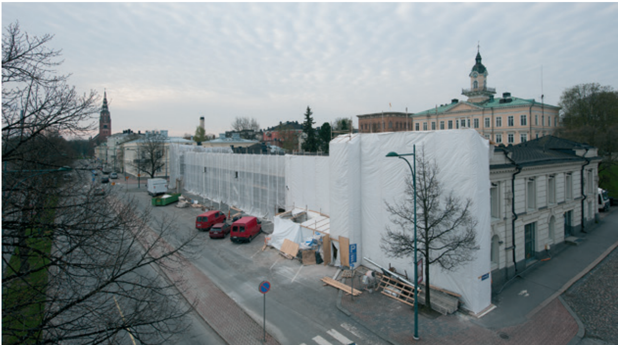
Porin taidemuseon julkisivun rappauksen uusiminen.
