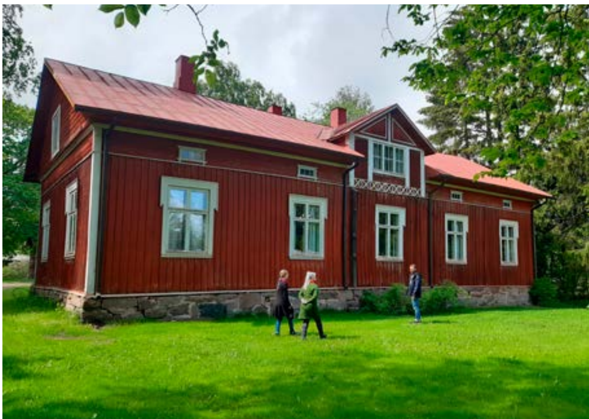
Neuvontakäynnillä Kiukaisten Wanhassa pappilassa rakennuskonservaattori Kalle Virtanen
