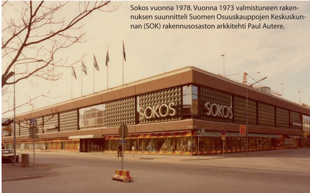
Sokokselle tunnusomainen vihreä muovikasettiverhoilu korvattiin harmaalla julkisivulevyverhoilulla vuonna 2003.
