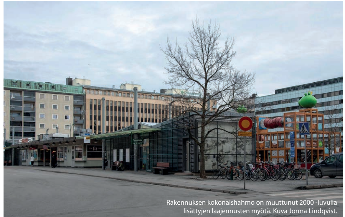
Kauppatorin kioski- ja käymälä-rakennus 1960-luvulla (yllä) ja vuonna 2019 (alla).
