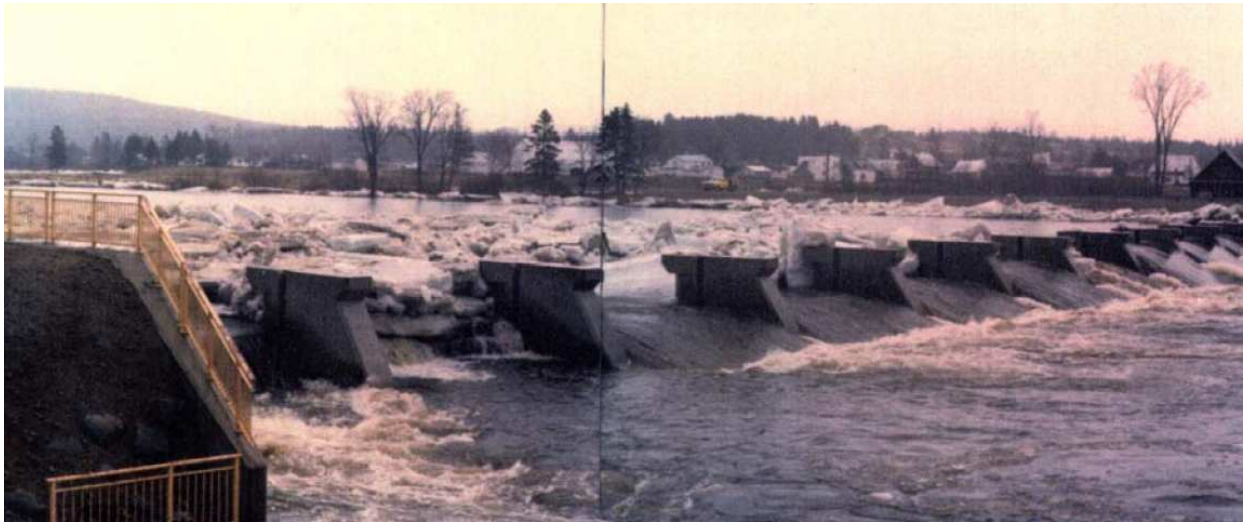
Kuva 1. Pohjapadon ja pilareiden avulla toteutettu jäänlähdön hallintarakenne Ste. Anne Riverjoella Quebecissa (Tuthill 2005).
