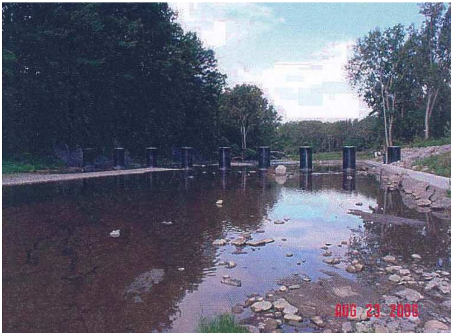
Kuva 6. Cazenovia Creekin jäänlähdon hallintarakenne valmiina (lähde: www.dec.ny.gov/docs/water_pdf/fcppjrczcrk.pdf ).
