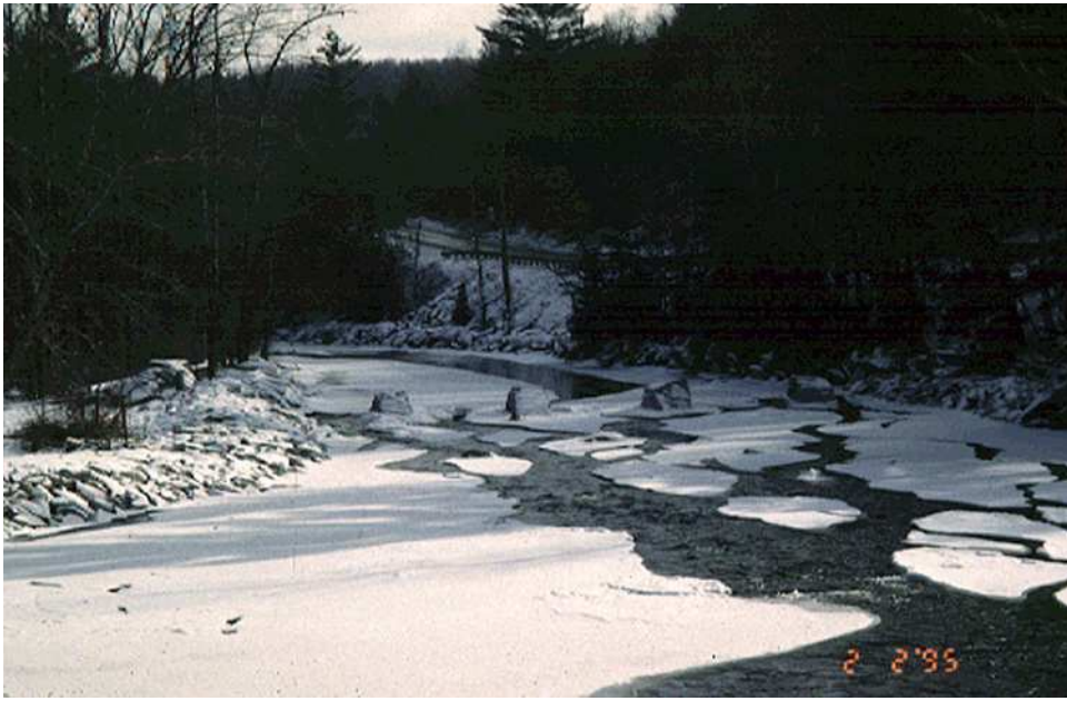
Kuva 3 a. Isoista uomaan asetetuista kivilohkareista muodostuva jäänlähdön hallintarakenne Lamoille River-joessa Vermontissa.
