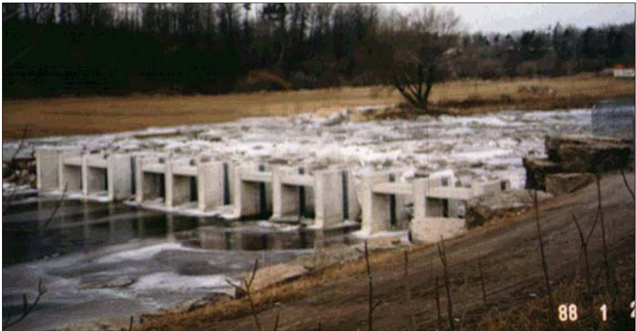
Kuva 2. Pilareiden avulla ilman pohjapatoa toteutettu jäänlähdön hallintarakenne Credit Riverjoella Ontariossa (Tuthill 2005).
