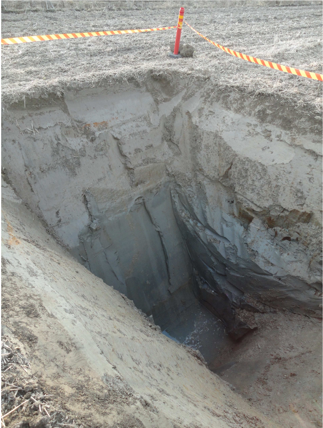
Kuva 5.7. Sisämaan kaivanto vuorokauden kuluttua kaivutyön aloittamisesta. (Heiskanen 2016)
