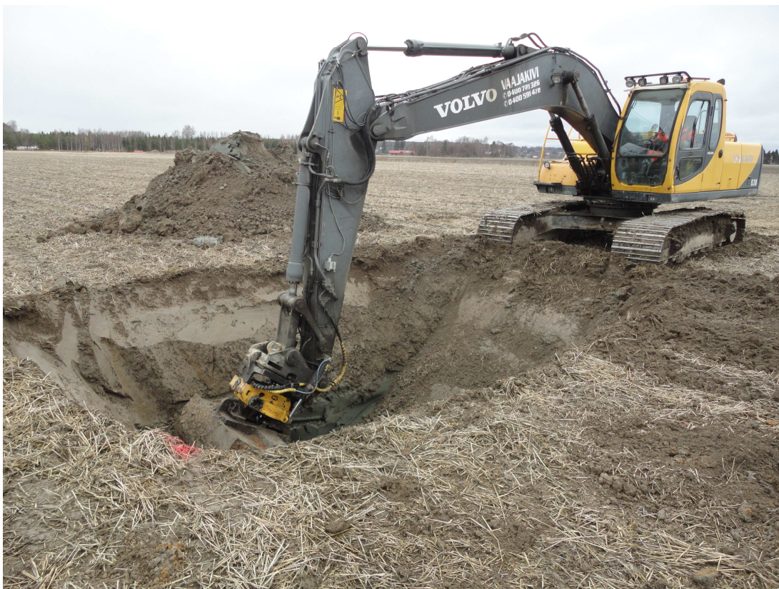
Kuva 5.2. Koekaivu työn alkuvaiheessa. (Heiskanen 2016)
