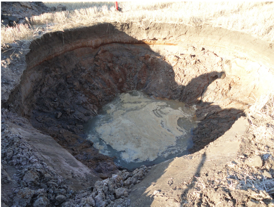
Kuva 5.5. Rannan kaivanto vuorokauden kuluttua kaivutyön aloittamisesta. (Heiskanen 2016)
