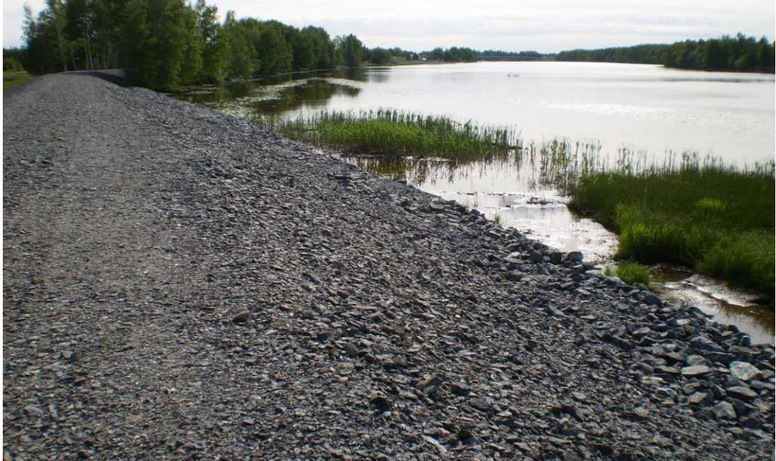
Kuva 3.5. Kokemäenjoen pohjoisrannan ensiapukorjauksissa vuonna 2008 tehty tulvapato.
