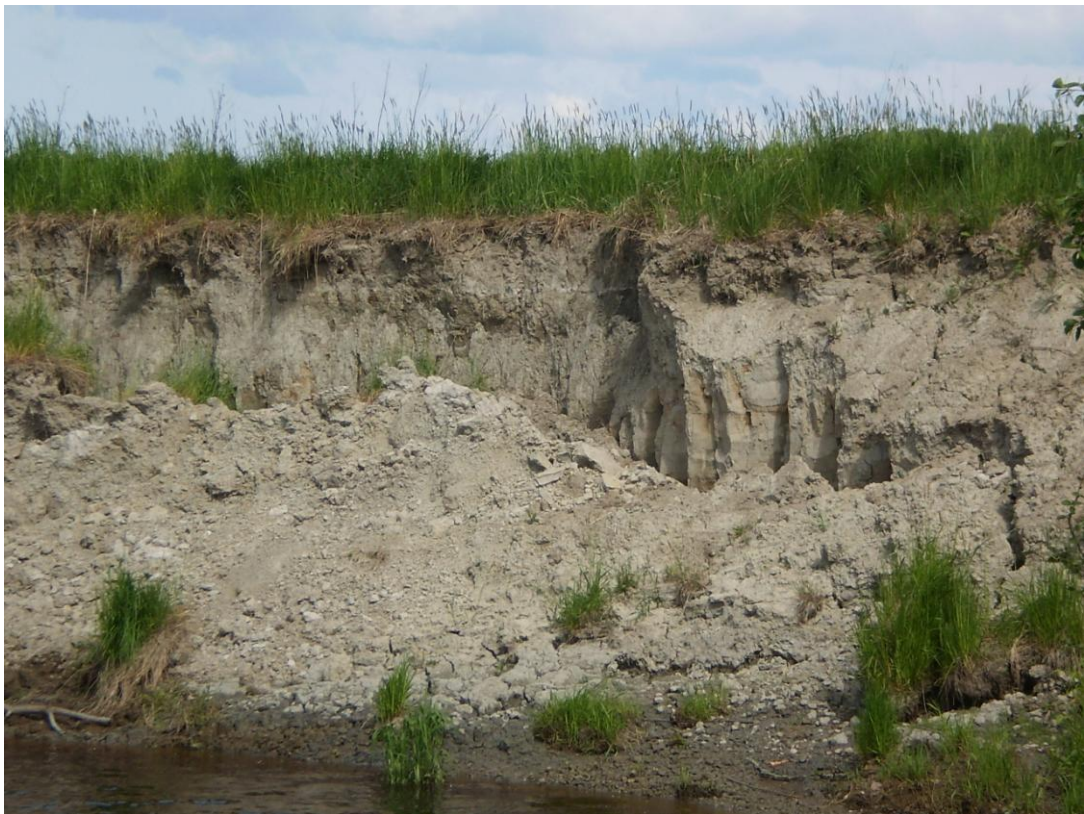
Kuva 6.14. Savisen siltin alueella Harjunpäänjoen pohjoisrannalla tapahtunut sortuma, jossa vain kapea luiska on sortunut.
