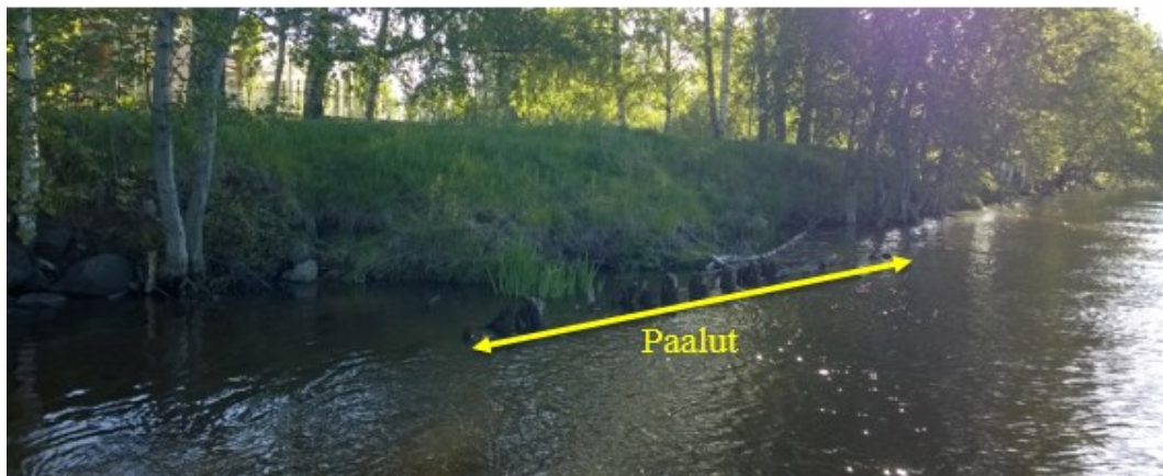
Kuva 56. Ajansaatossa Luotsinmäenhaarassa paalujen takana oleva joen törmä on erodoitunut.
