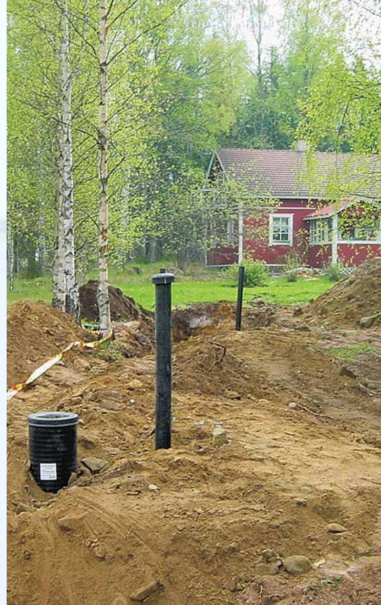
Kiinteistökohtaiseen jätevesien käsittelyyn liittyvän maasuodatuskentän rakentaminen. Kuva: Porin kaupunki, ympäristövirasto.
