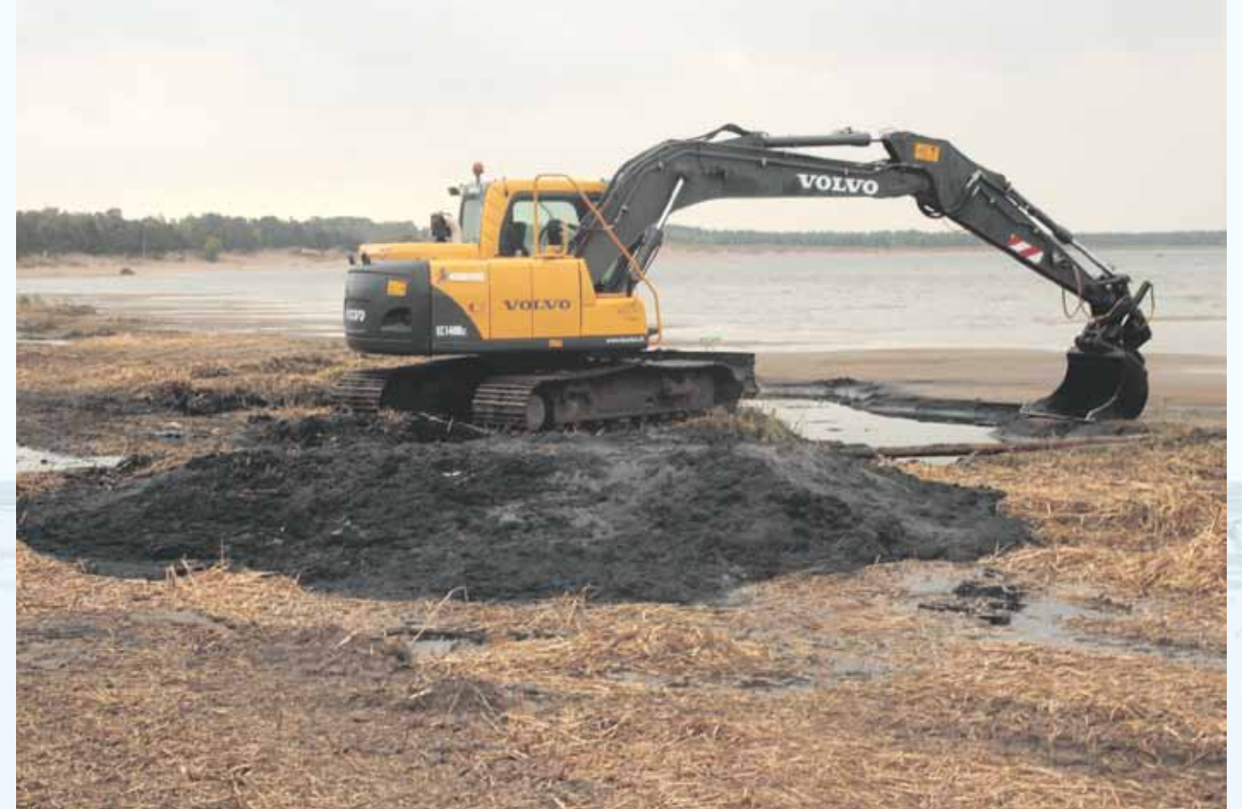
Levämassan poistoa Yyterissä. Itämeren rehevöitymisen seurauksena Yyterin hiekkarannalle kertyy viherlevää. Kuva: Kimmo Nuotio.
