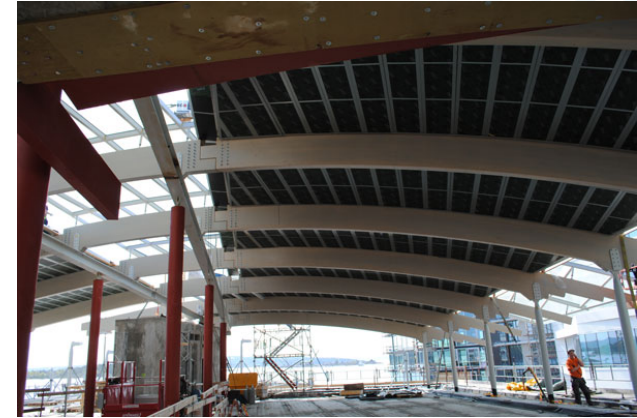
Austrup Faernley Museum, Oslo Kuva: Foamglas Nordic, Owens Corning
