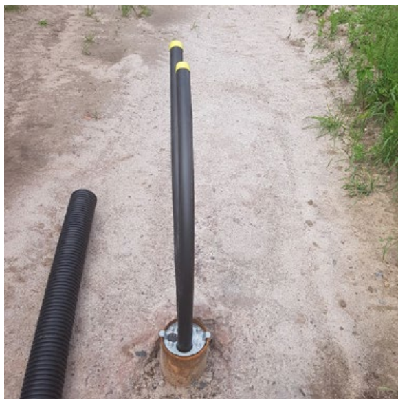
Kuva 2. Pienelle tontille voidaan porata lämpökaivo maalämpöpumpun varten. (Kuva: Sanna Lindgren)
