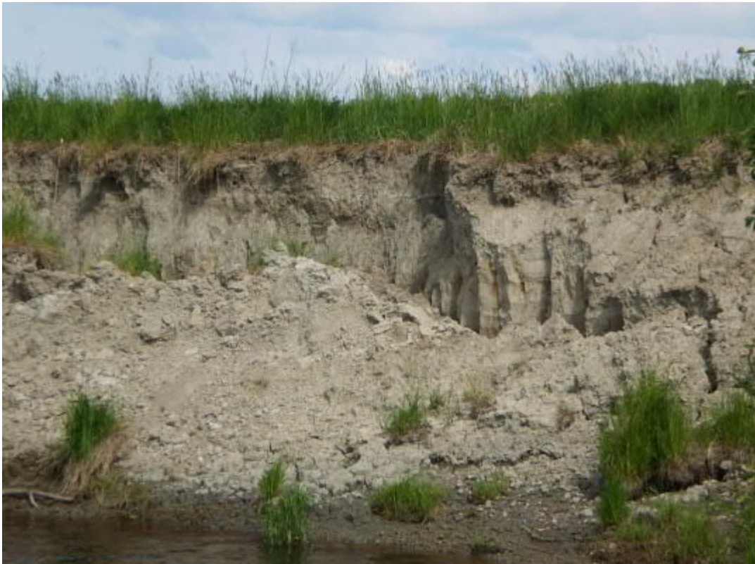
Kuva 7-1 Savisen siltin alueella Harjunpäänjoen pohjoisrannalla tapahtunut sortuma, jossa vain kapea luiska on sortunut (Ketonen 2009).
