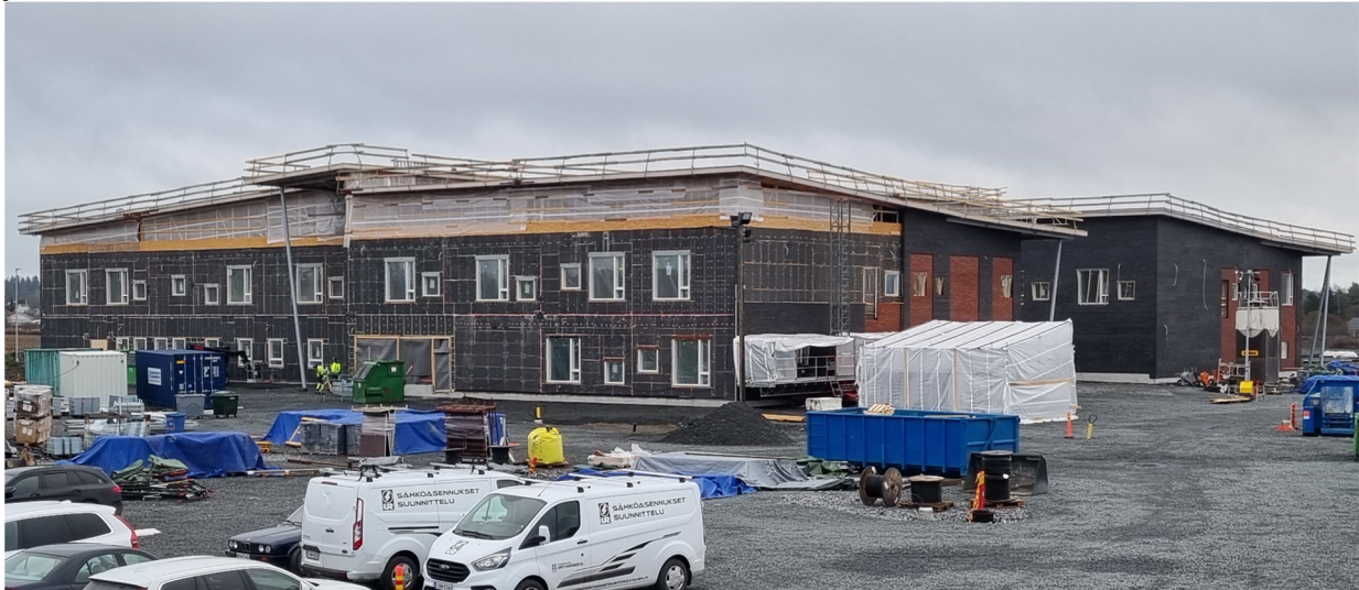
Kuva työmaatoimiston portaalta 4.11.2022.
