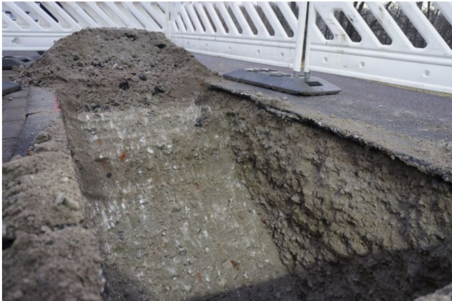
Kuva 2. Aukikaivettu betonimurskerakenne (Taavi Dettenborn 2014)
