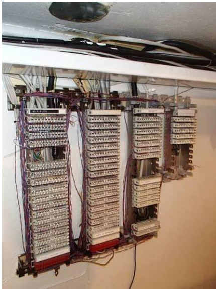
Puhelinjärjestelmän laitteita ja kytkentäpisteitä kellarikerroksen pääteletilassa sekä ryhmäkeskomerossa.
