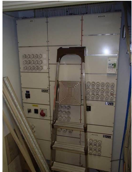
Ryhmäkeskuksia on uusittu mm. 1991-laajennuksen ja 2005 peruskorjauksen yhteydessä.
