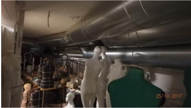
Eristettyä ilmanvaihtokanavistoa.
