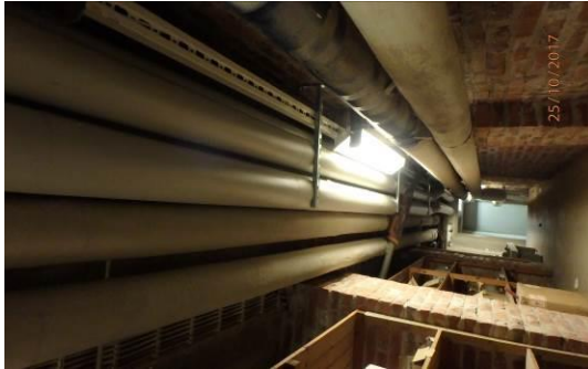
Lämpö- ja vesijohtoverkoston putkien eristyksiä.
