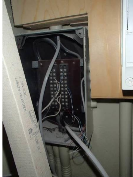
Puhelinjärjestelmän laitteita ja kytkentäpisteitä kellarikerroksen pääteletilassa sekä ryhmäkeskomerossa.
