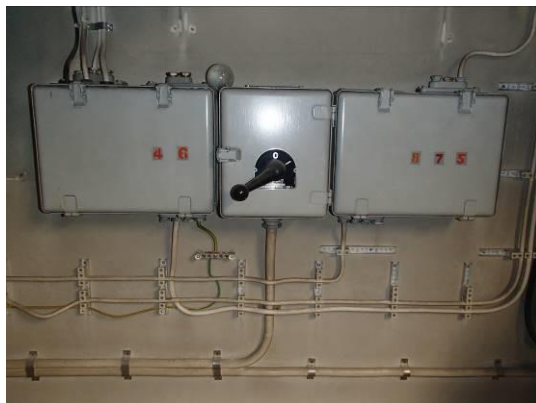
Kellarikerroksen länsipäässä olevien 2kpl lvi-ryhmäkeskuksien käyttöikä alkaa olla lopussa. Nämä keskuksat tulisi uusia seuraavien ko. tilojen muutostöiden yhteydessä.
