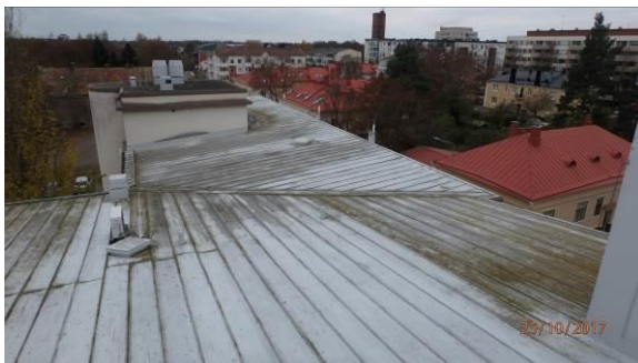
Erillisiä huippuimureita on kaksi rakennuksen katolla.
