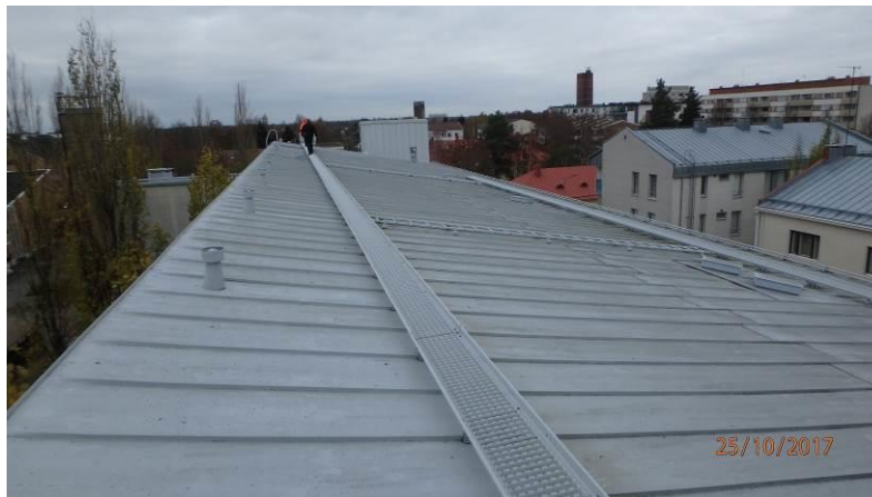
Korkean osan vesikattovarusteet ovat kunnossa
