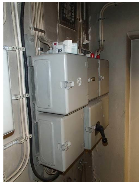
Kellarikerroksen länsipäässä olevien 2kpl lvi-ryhmäkeskuksien käyttöikä alkaa olla lopussa. Nämä keskuksat tulisi uusia seuraavien ko. tilojen muutostöiden yhteydessä.
