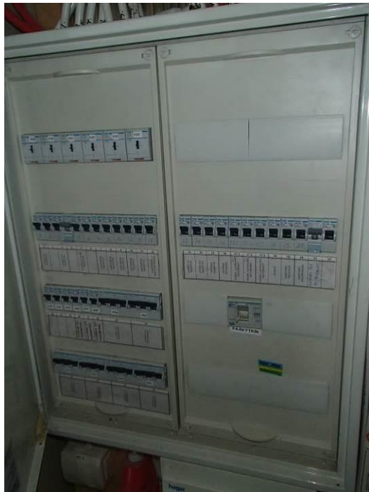
Ryhmäkeskuksia on uusittu mm. 1991-laajennuksen ja 2005 peruskorjauksen yhteydessä.
