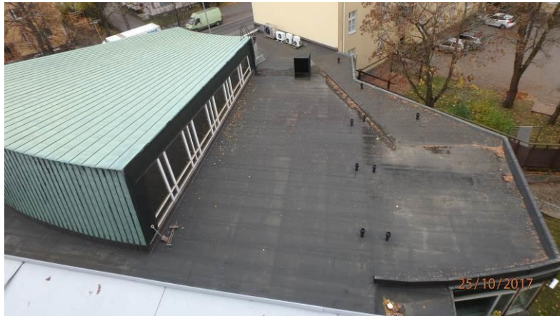
Yleiskuvia ruokalan vesikatolta.
