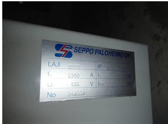
Sähköpääkeskus on vuodelta 1994 ja se on edelleen hyvässä kunnossa. Nimellisvirta on 1000A.
