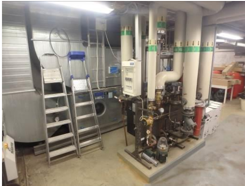
Kiinteistön lämmönjakokeskus.
