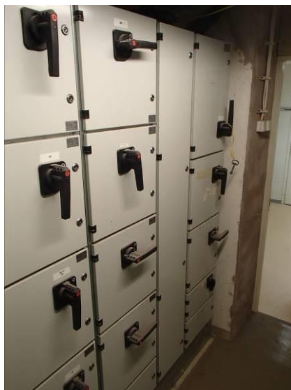
Sähköpääkeskus on vuodelta 1994 ja se on edelleen hyvässä kunnossa. Nimellisvirta on 1000A.
