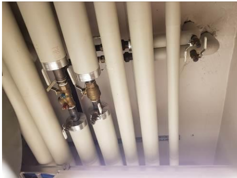
Lämmitysverkoston venttiileitä ja putkikytöntöjä.
