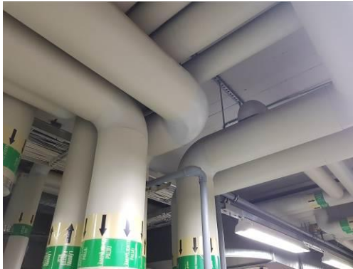
Iv-verkoston putkien eristyksiä.
