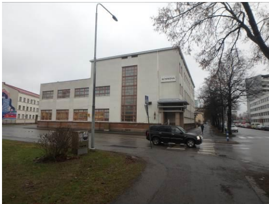
Julkisivut ovat pääosin rapattuja. Sokkelit ovat betonia ja luonnonkiveä.
