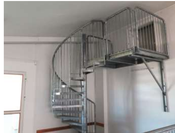
Uusi teräskierreporras rakennettiin neljännestä kerroksesta ullakolle.
