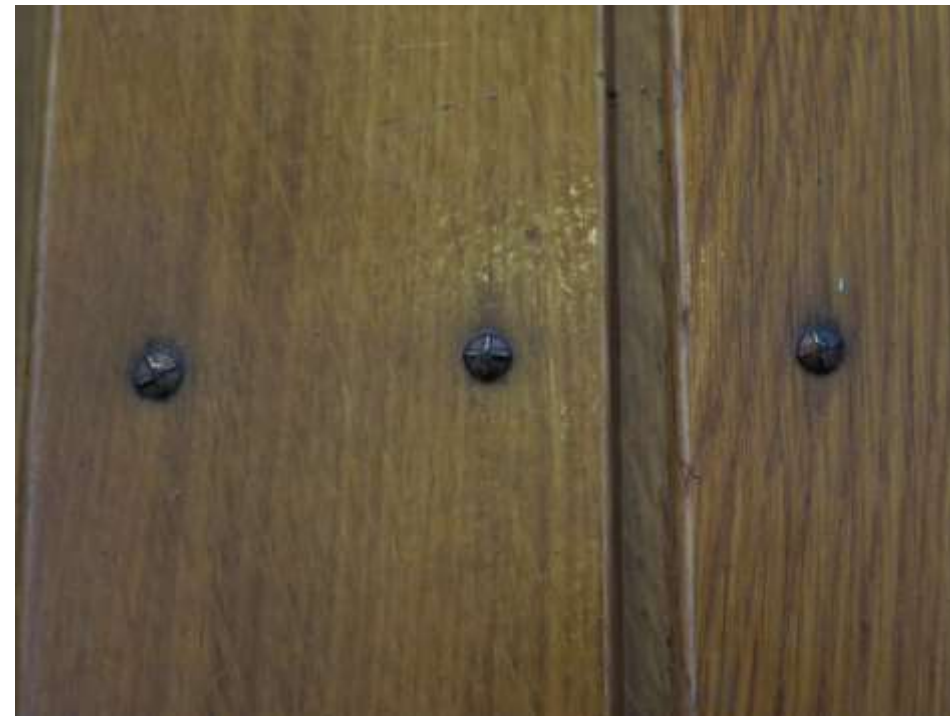
Tammiverhoukset on kiinnitetty kuparinauloilla.
