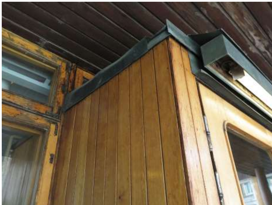
Sisääntulohallin molempien tuulikaappien kaikki näkyvät puuosat on tehty tammiponttilaudasta.
