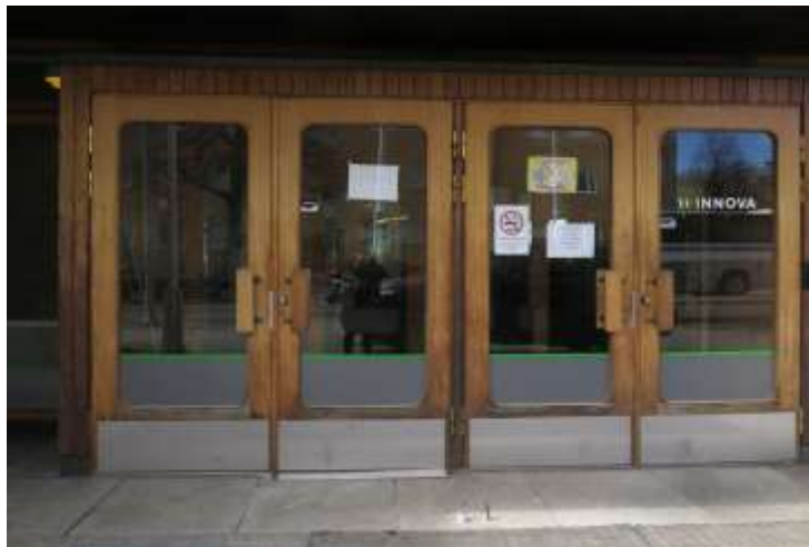
Sisääntulohallin molempien tuulikaappien kaikki näkyvät puuosat on tehty tammiponttilaudasta.
