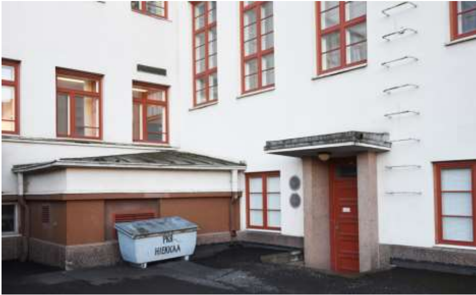
Ulkoseinien patterisyvennysten taustalla on kaksinkertainen ensoniittieristys ja ikkunalaudat ovat betonirakenteisia.
