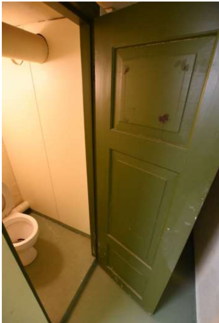
Alkuperäisiä sisäovia on säilynyt pääosin kellarin väestönsuojassa.
