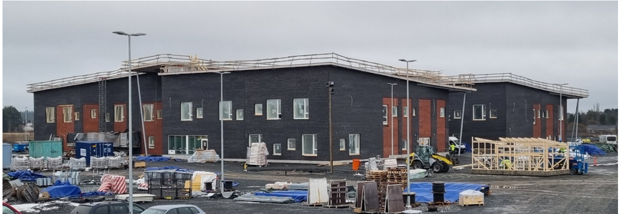
Kuva työmaatoimiston portailta 17.2.2023
