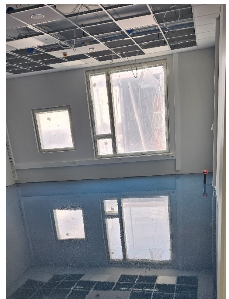
B2.krs PU-lattiaa ja alakattoa
