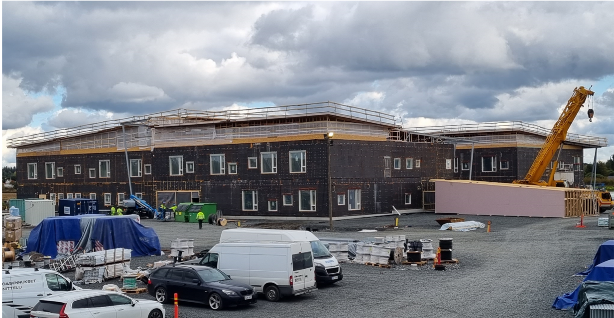
Kuva työmaatoimiston portaalta 23.9.2022.
