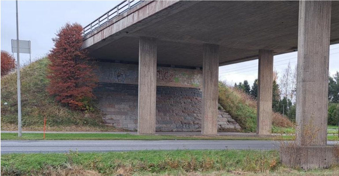
Kuva 5 Sillan alla olevat luonnonkiviverhoillut luiskat.
