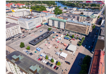
Kauppatorin uudistuminen alkoi uuden Toripaviljongin myötä. Rakennus valmistui vapuksi 29.4.2020. Toripaviljongissa toimivat nykyään Hesburger ja R-kioski. Siellä on myös torikauppiaiden käytössä oleva varasto ja yleisö wc:t. Kuva Tomi Glad.
