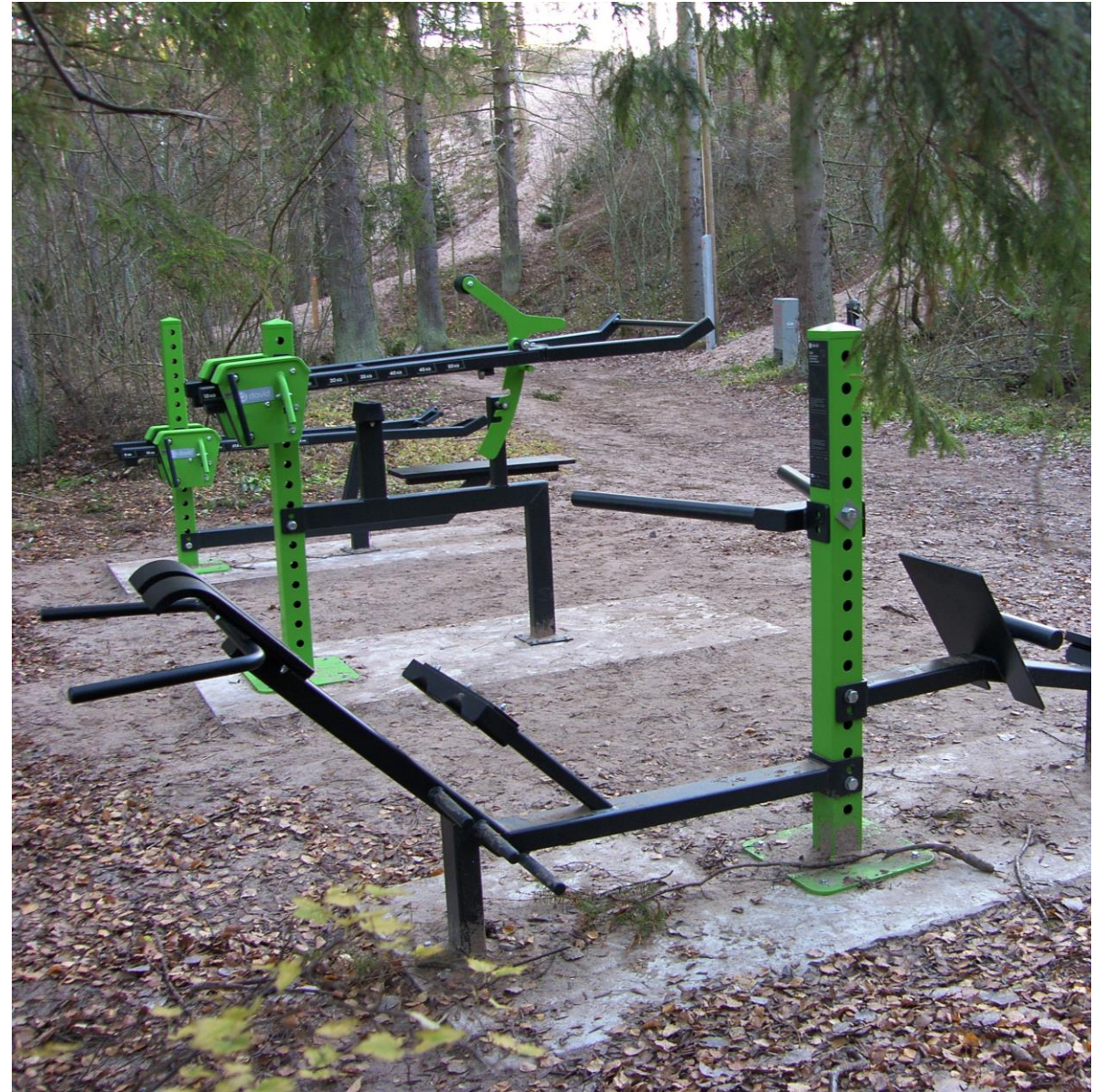
Kuntopolun varrelle rakennettiin ulkokuntosali
