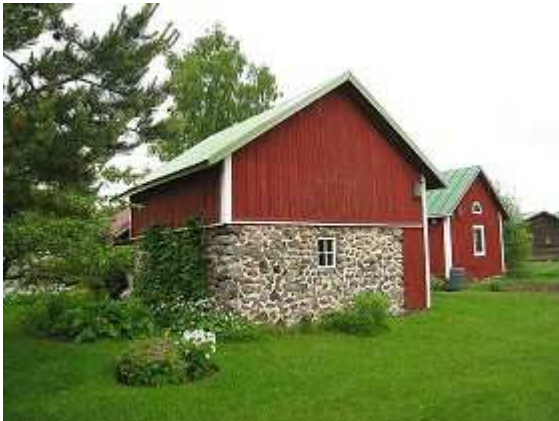
Kannikaupungin hyvin säilynyttä ulkorakennuskantaa maisemallisesti merkittäväällä paikalla. Koskelan rakennuksia. Kuvaaja: Olli Joukio 11.6.2010.
